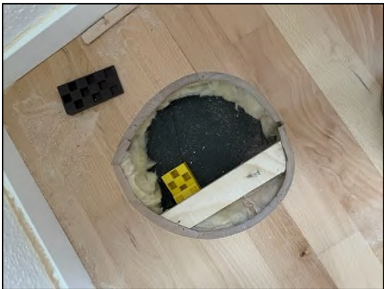
Boring 2: Foto af gennembrydning af gulv
