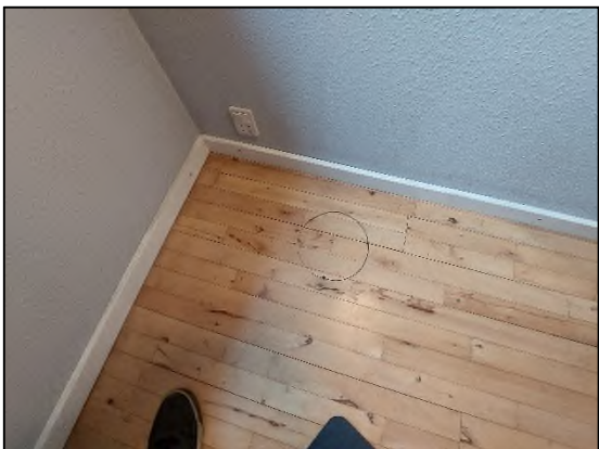
Boring 3: Foto af gennembrydning af gulv
