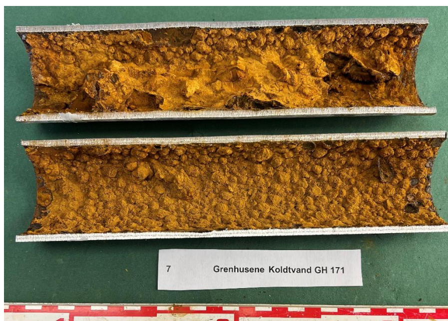
Figur 14 Grenhusene, Koldt vand GH 171. Rørprøve efter langsgående gennemskæring.
