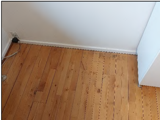
Boring 4: Foto af gennembrydning af gulv
