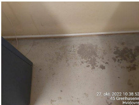
Boring 12: Foto af gulv før gennembrydning
