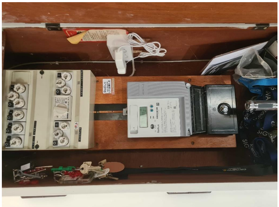
Nr. 147: Måler- og gruppetavle med gruppemateriel, der skønnes til at være mere end 30 år. Fejlstrømsrelæ er en ældre HPFI- afbryder
