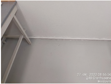
Boring 11: Foto af gulv før gennembrydning
