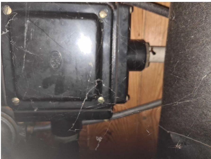
Nr. 8: Nyere stigeledning samlet med oprindelig armeret stofkabel
