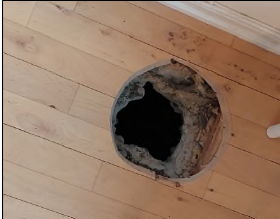
Boring 1: Foto af gennembrydning af gulv
