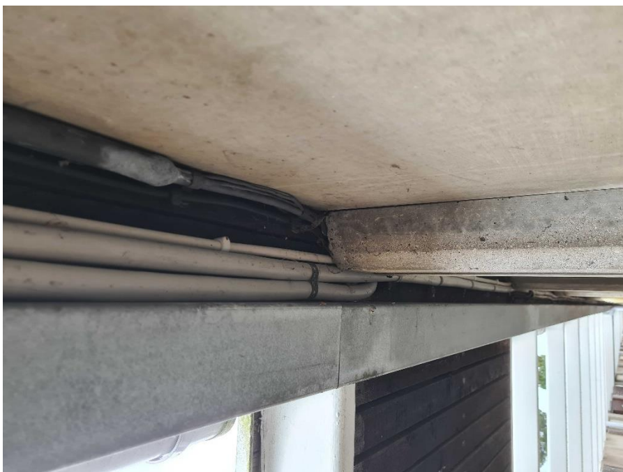
Nr. 8: Nyere stigeledninger
